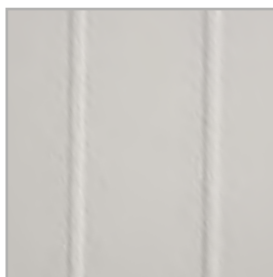
frezowanie na powierzchni skrzydła
