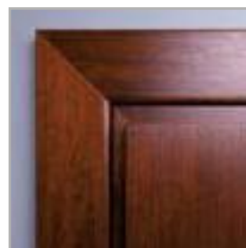
łączenie opasek pod kątem 45°
